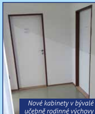
Zmodernizovaná chodba 2. patra
